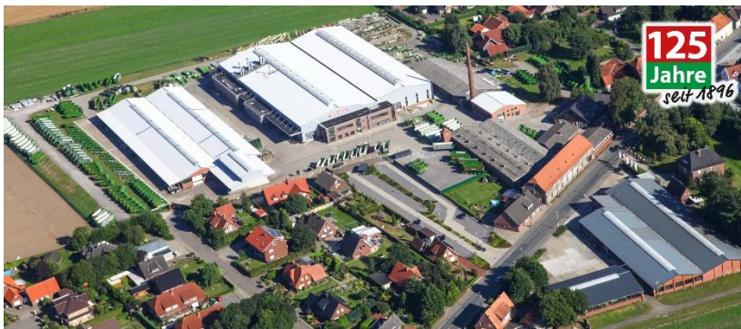
Bild: Blick über das Werksgelände mit Produktionshallen und Verwaltungsgebäude sowie Ersatzteillager.
